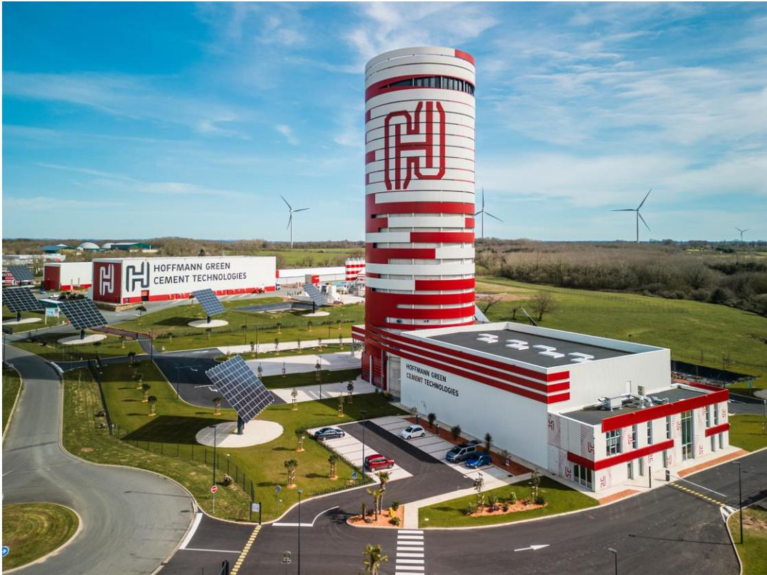
L'unité de production « H2 » de 70 mètres de haut, reposant sur un process « gravitaire » et entièrement construite en béton Hoffmann Green, a une capacité de production d'environ 400 000 tonnes de ciment par an en 3 x 8. Ce modèle d'unité est celui qui sera dupliqué pour les développements en France et à l'international de la Société.
