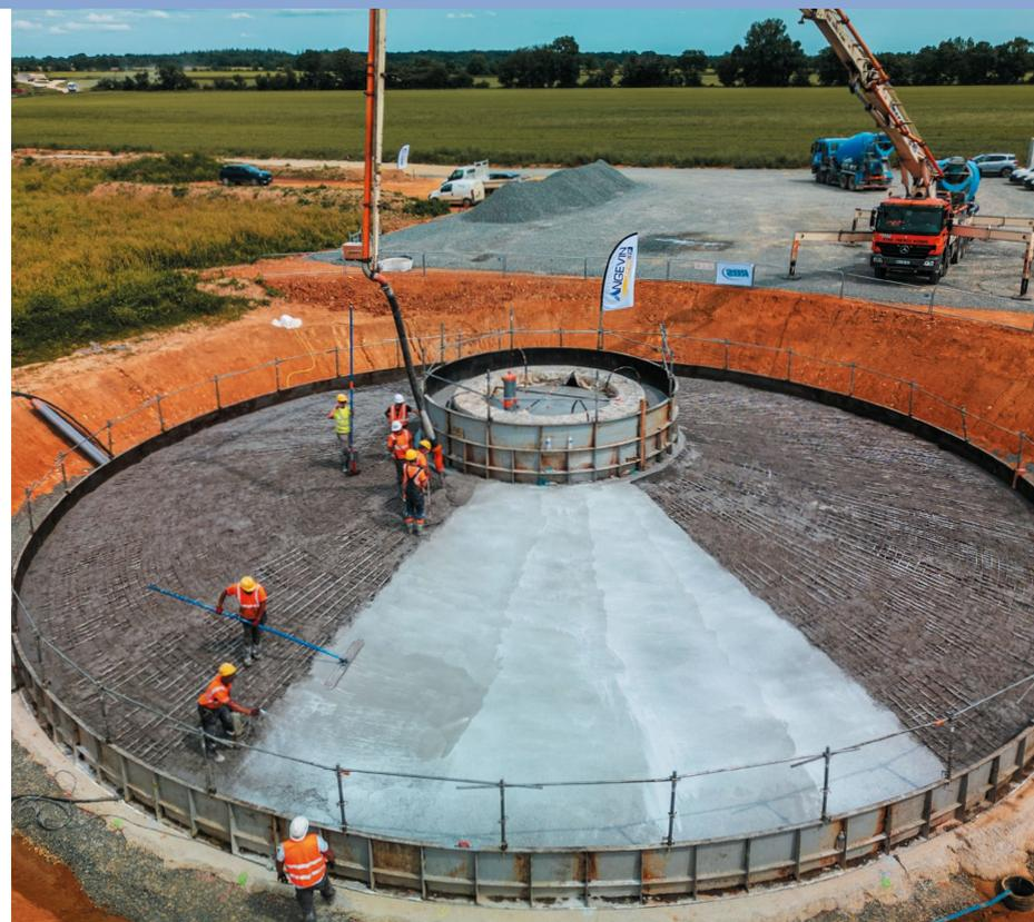
Parc éolien de la Plaine des Moulins à Jazeneuil (Vienne), coulage d'une fondation d'éolienne exclusivement réalisée en béton décarboné 0% clinker.
