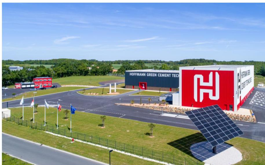
Loin de l'image des cimenteries traditionnelles, ce premier site de production « H1 », d'une capacité de production de 50.000 tonnes de ciments Hoffmann Green par an (en 2x8)<sup>29</sup>, ne comporte ni four ni cheminée et ne produit pas de déchets. Il est par ailleurs doté de 3 trackers solaires qui fournissent 25% de la consommation énergétique du site<sup>30</sup>.
