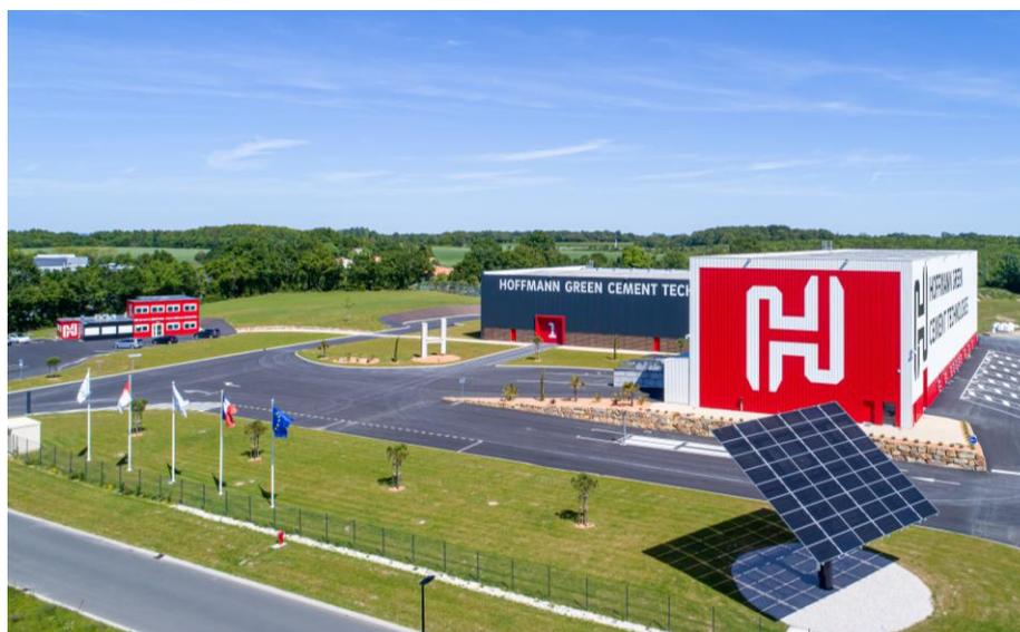
Loin de l'image des cimenteries traditionnelles, ce premier site de production « H1 », d'une capacité de production de 50.000 tonnes de ciments Hoffmann Green par an (en 2x8)<sup>28</sup>, ne comporte ni four ni cheminée et ne produit pas de déchets. Il est par ailleurs doté de 3 trackers solaires qui fournissent 25% de la consommation énergétique du site<sup>29</sup>.
