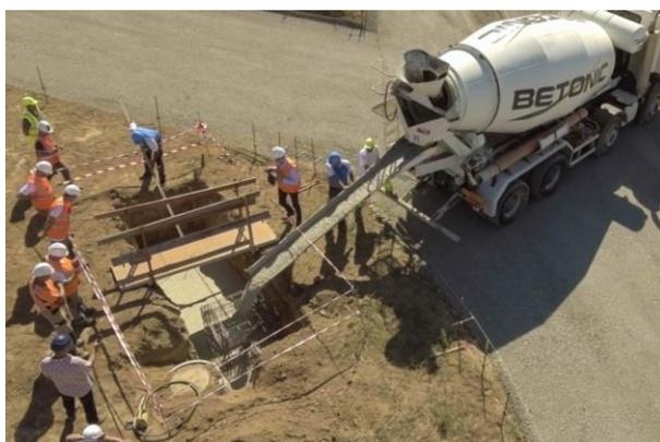
Les ciments Hoffmann Green ont également été utilisés dans le cadre de coulages de dalles de béton (Chaillé-sous-les-Ormeaux, 350 m<sup>2</sup> pour la société Argilus) et de fondations chez LG Béton dans le cadre de l'extension d'un de leurs bâtiments industriels (environ 30 tonnes de ciments Hoffmann Green).
